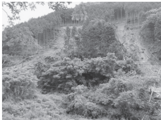
間伐施業に敷設された大型機械を入れるための幅広作業道の崩壊
