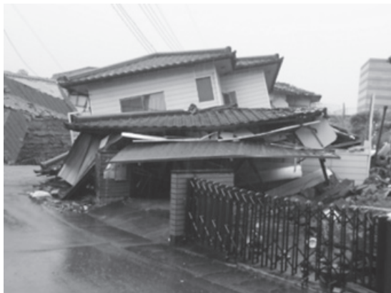
【写真】地震被害の写真(平成28年熊本地震)
