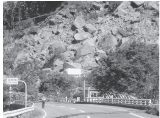
【写真】地震被害の写真(平成16年新潟県中越地震)
